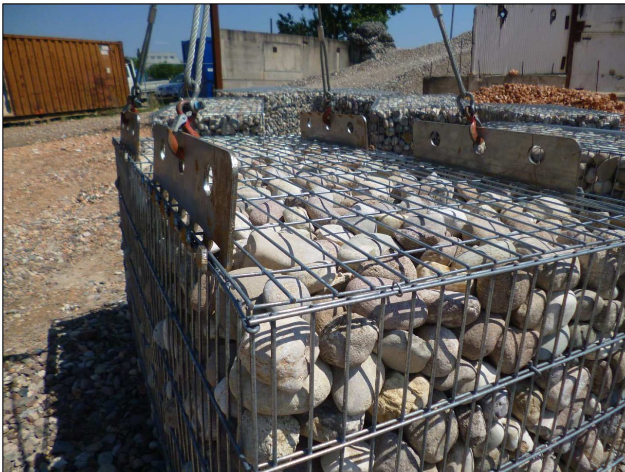
Fig.25 - Distribuzione dei Pettini ML nel caso di una gabbia da 2 mc –
