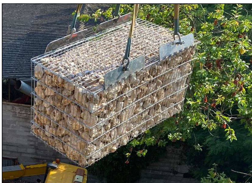
Fig.2 – Movimentazione del gabbione pieno di materiale lapideo con Pettine ML –
