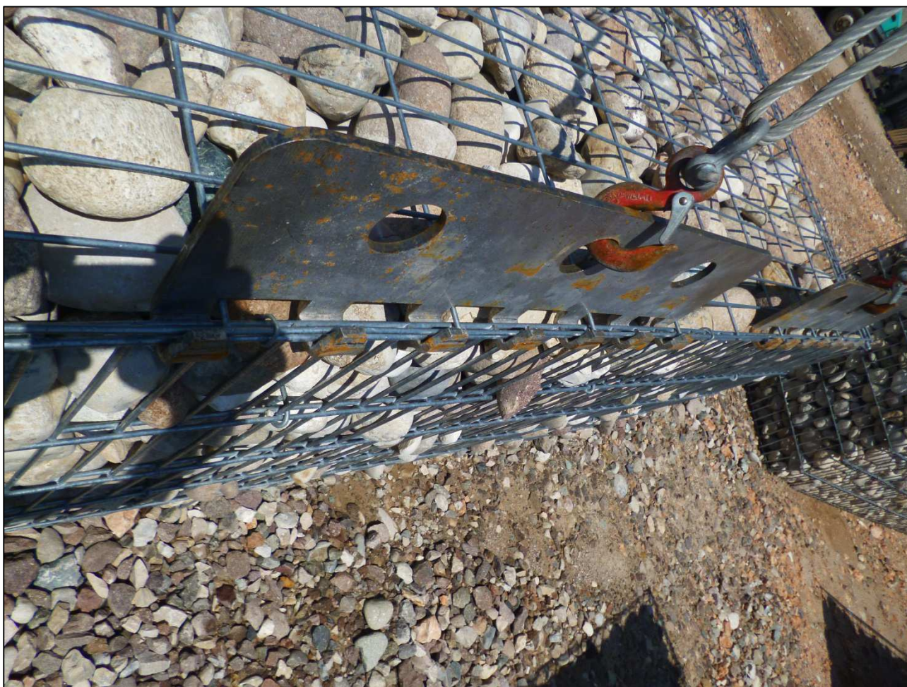
Fig.24 - Utilizzo del Pettine ML con i denti verso l'esterno -
