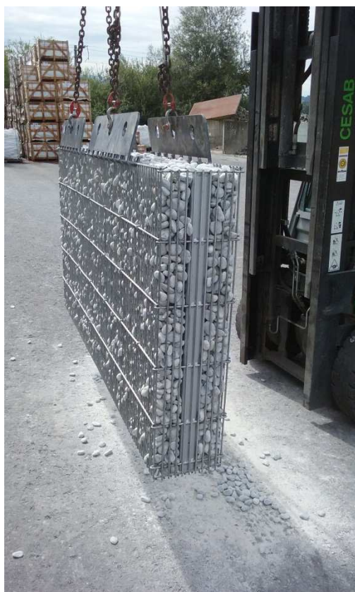
Fig.1 – Esempio di utilizzo dell'accessorio di sollevamento " Pettine JM " –
