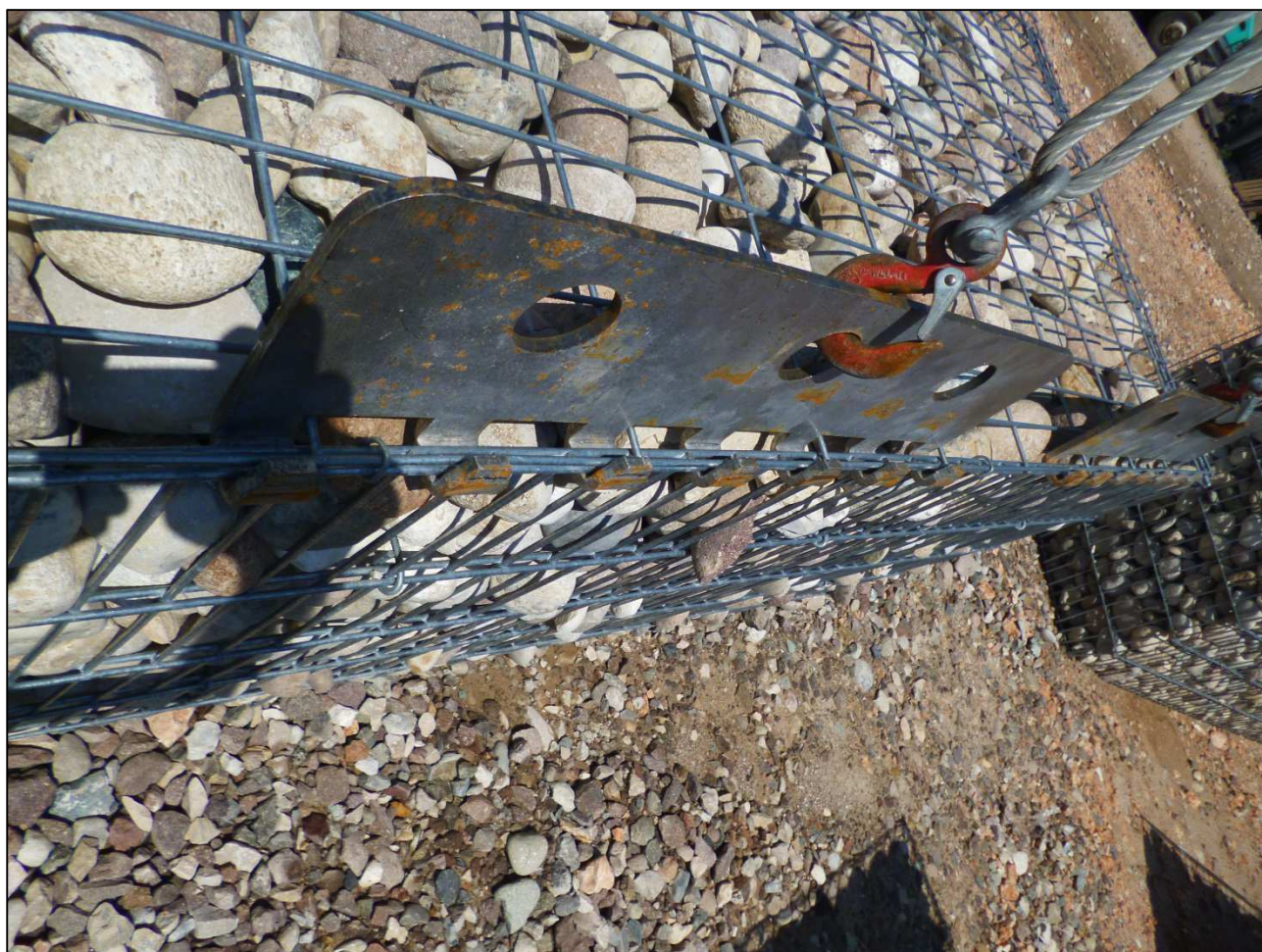
Fig.5 - Esempio di utilizzo dei Pettini con i denti verso l'esterno -
